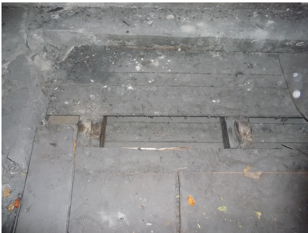
Fot. 30 Budynek szkolny ul. Bocheńskiego 149 – drewniany strop nad salą gimnastyczną.
