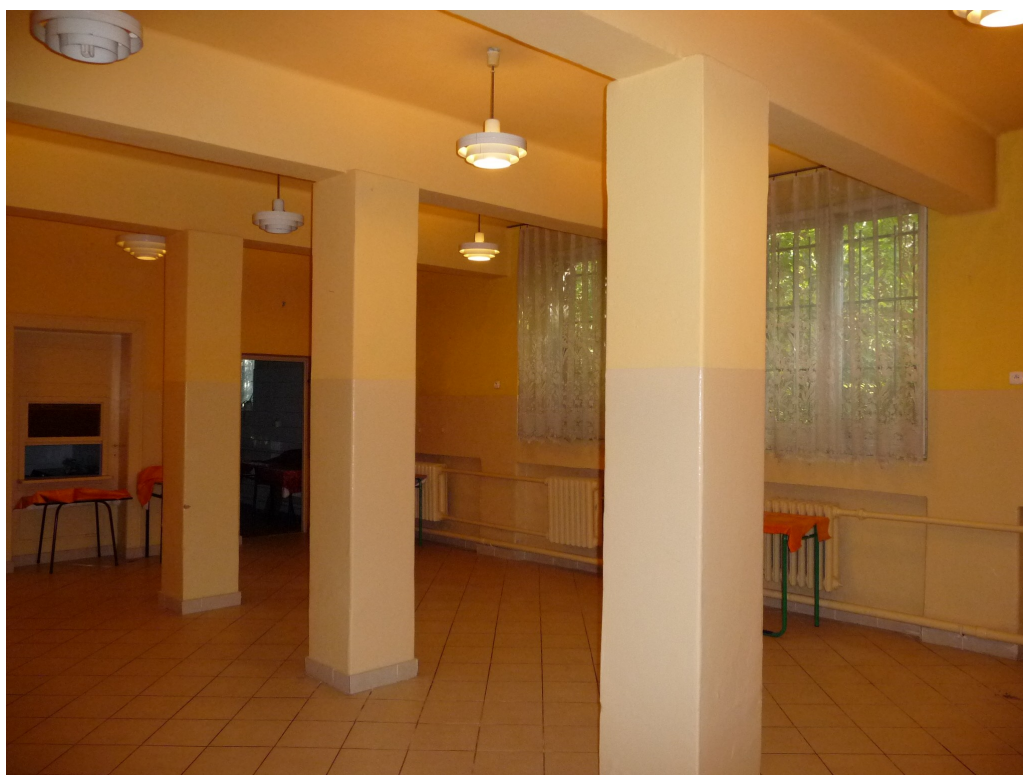
Fot. 24 Budynek szkolny ul. Bocheńskiego 149 – żelbetowe słupy i podciągi w stołówce zlokalizowanej w piwnicy.
