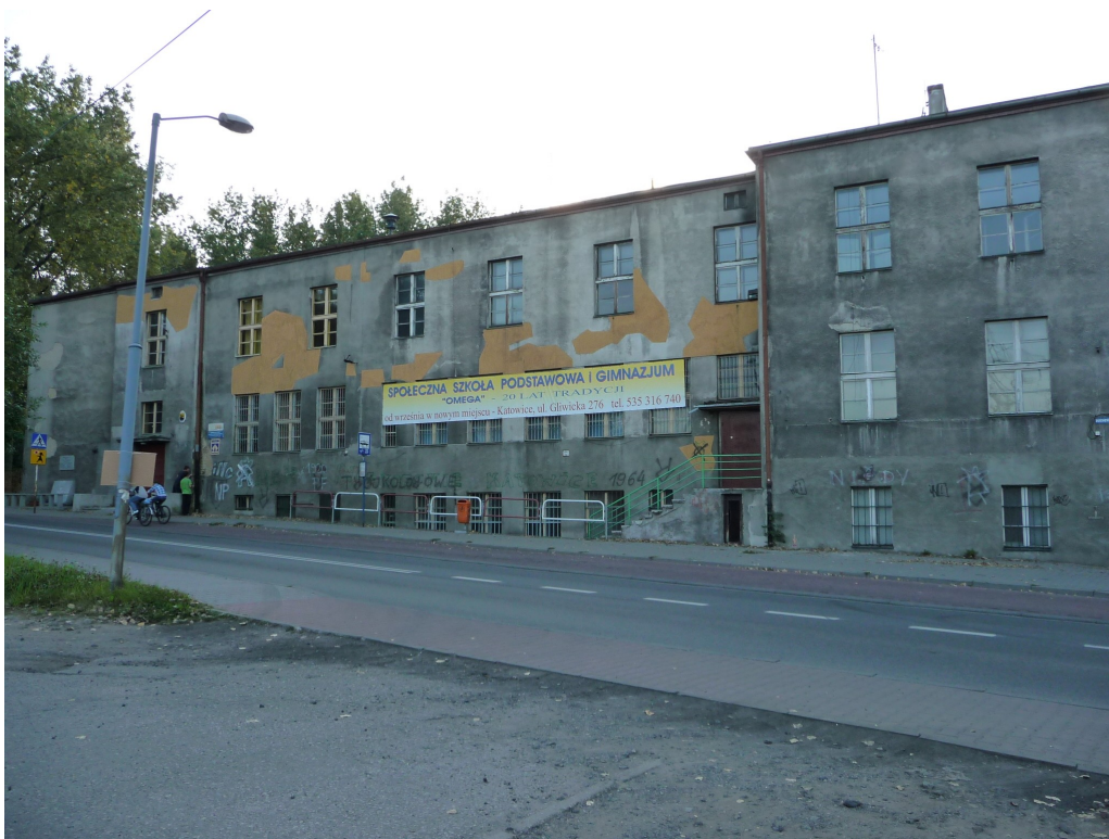
Fot. 2 Budynek szkolny ul. Bocheńskiego 149 – elewacja wschodnia zewnętrzna od ul. Bocheńskiego
