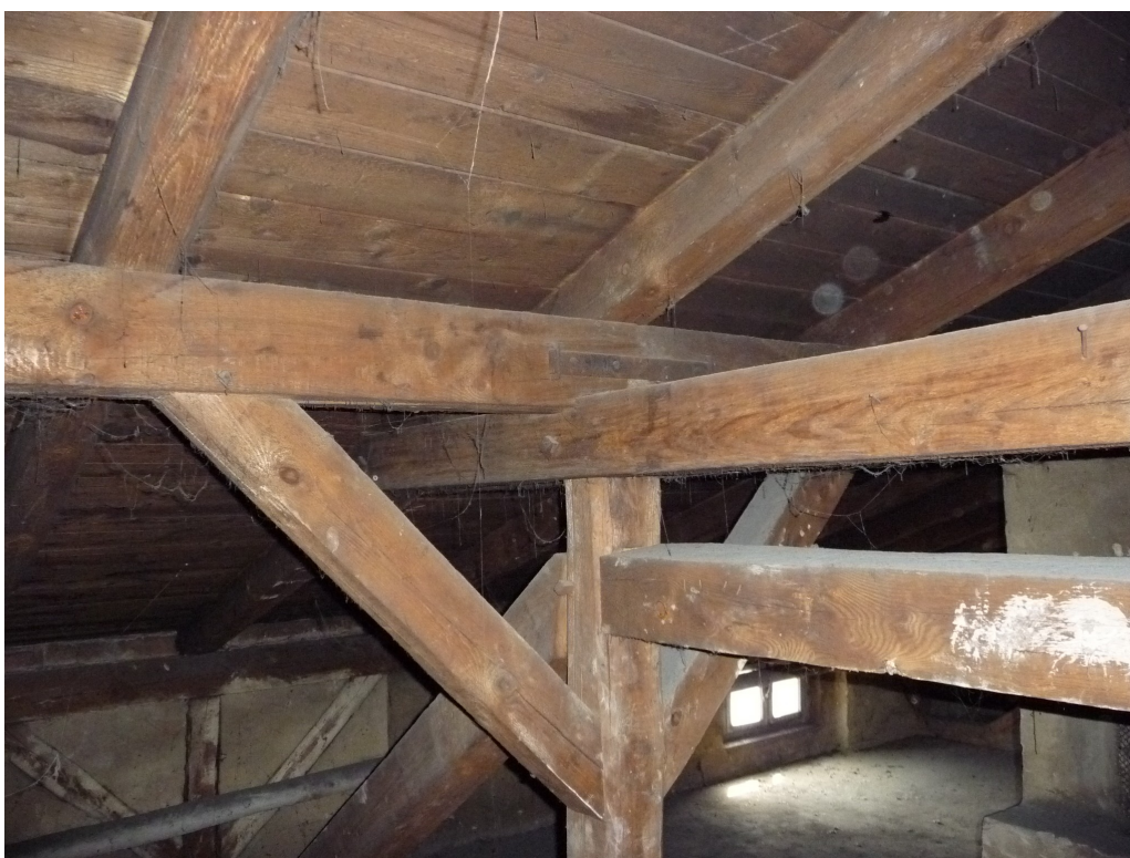
Fot. 26 Budynek szkolny ul. Bocheńskiego 149 – drewniana konstrukcja dachu.
