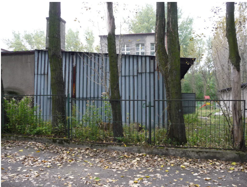
Fot. 11 Budynek gospodarczy B ul. Bocheńskiego 149 – elewacja północna.
