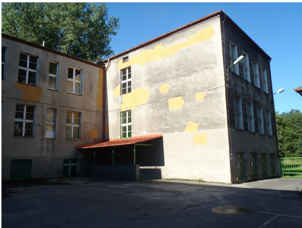
Fot. 5 Budynek szkolny ul. Bocheńskiego 149 – elewacja północna część szkolna i wschodnia wewnętrzna od dziedzińca.
