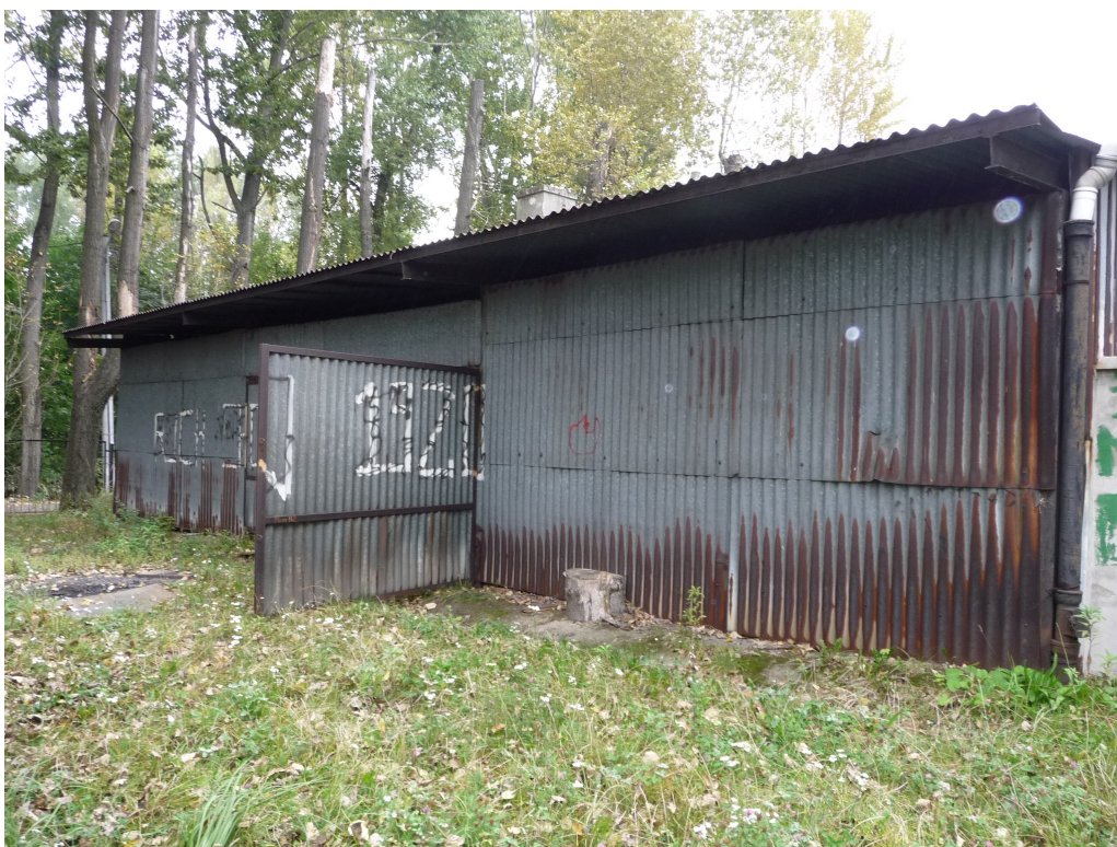
Fot. 10 Budynek gospodarczy B ul. Bocheńskiego 149 – elewacja zachodnia.
