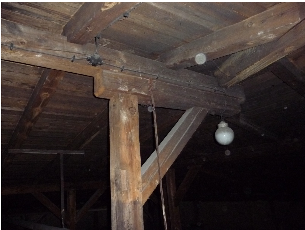
Fot. 27 Budynek szkolny ul. Bocheńskiego 149 – drewniana konstrukcja dachu.
