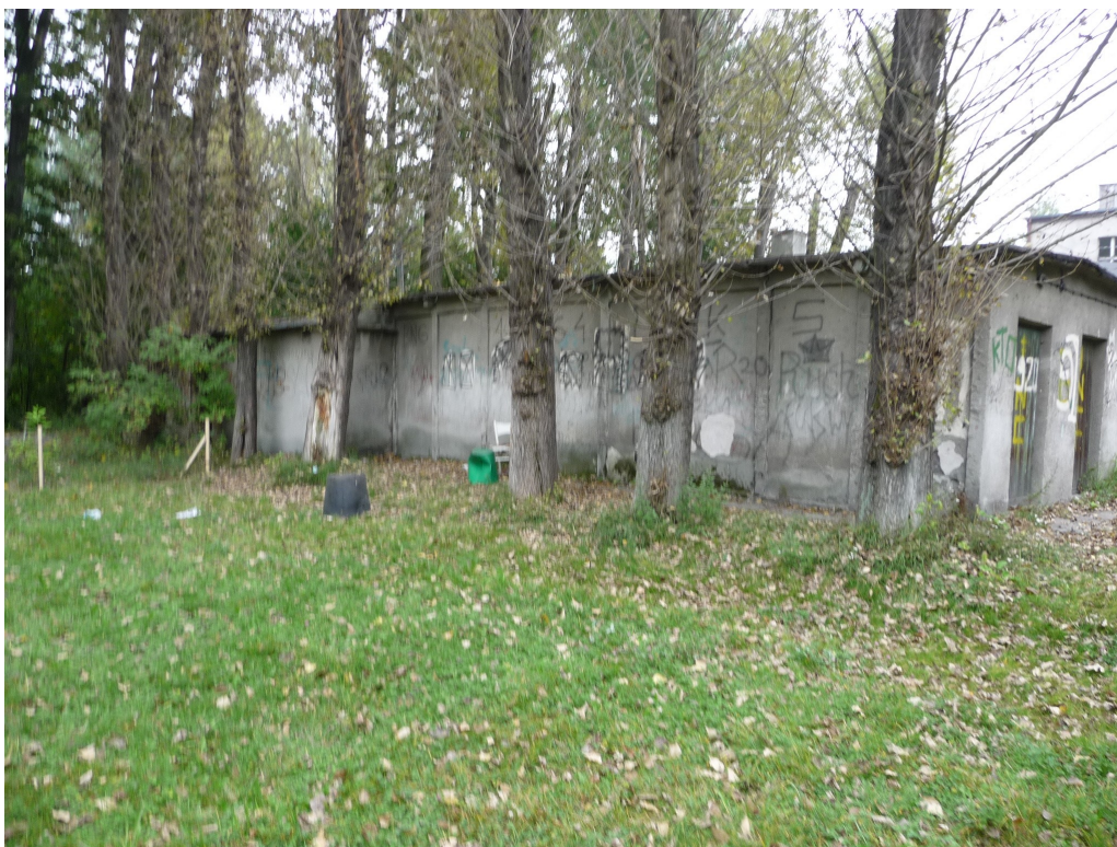
Fot. 15 Budynek gospodarczy C ul. Bocheńskiego 149 – elewacja zachodnia.
