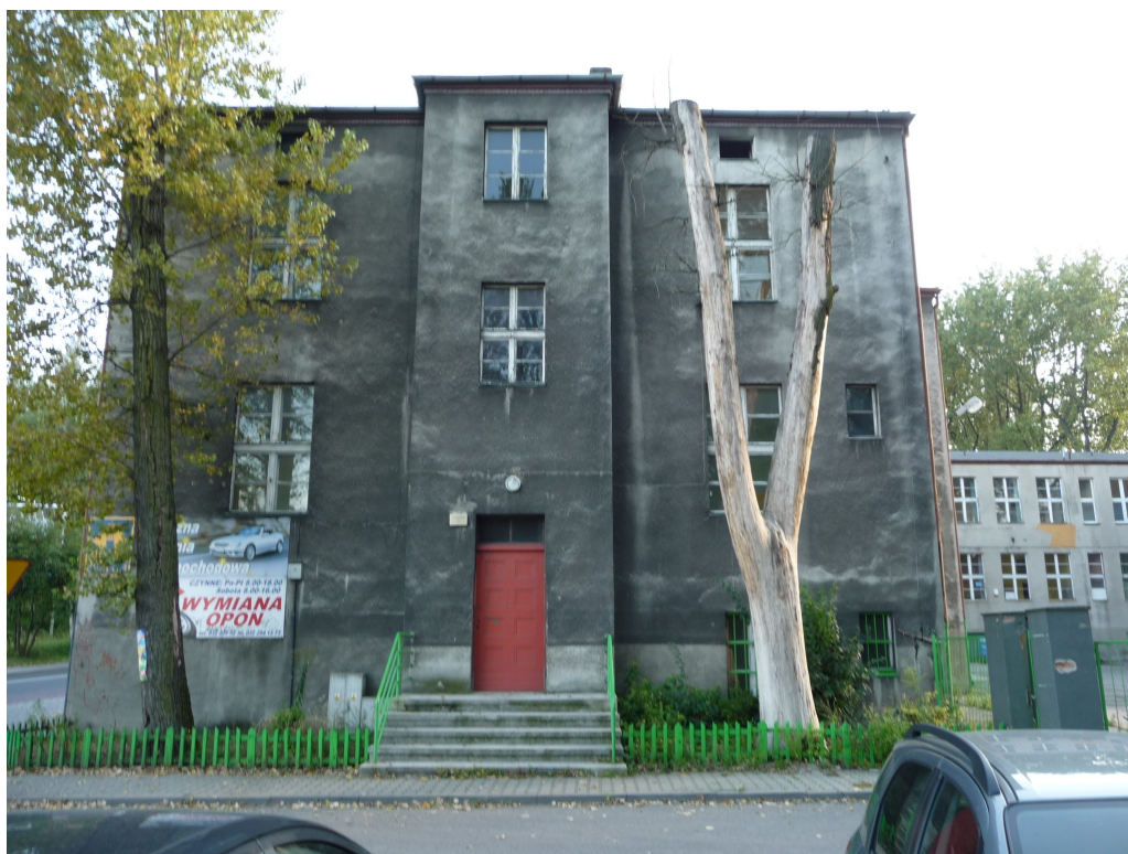
Fot. 3 Budynek szkolny ul. Bocheńskiego 149 – elewacja północna część mieszkalna
