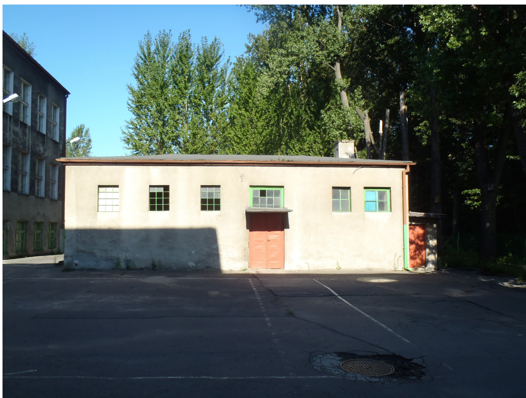
Fot. 8 Budynek gospodarczy A ul. Bocheńskiego 149 – elewacja wschodnia.
