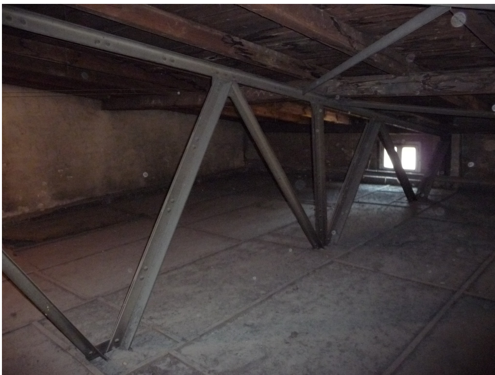
Fot. 28 Budynek szkolny ul. Bocheńskiego 149 – stalowa kratownica nad salą gimnastyczną.
