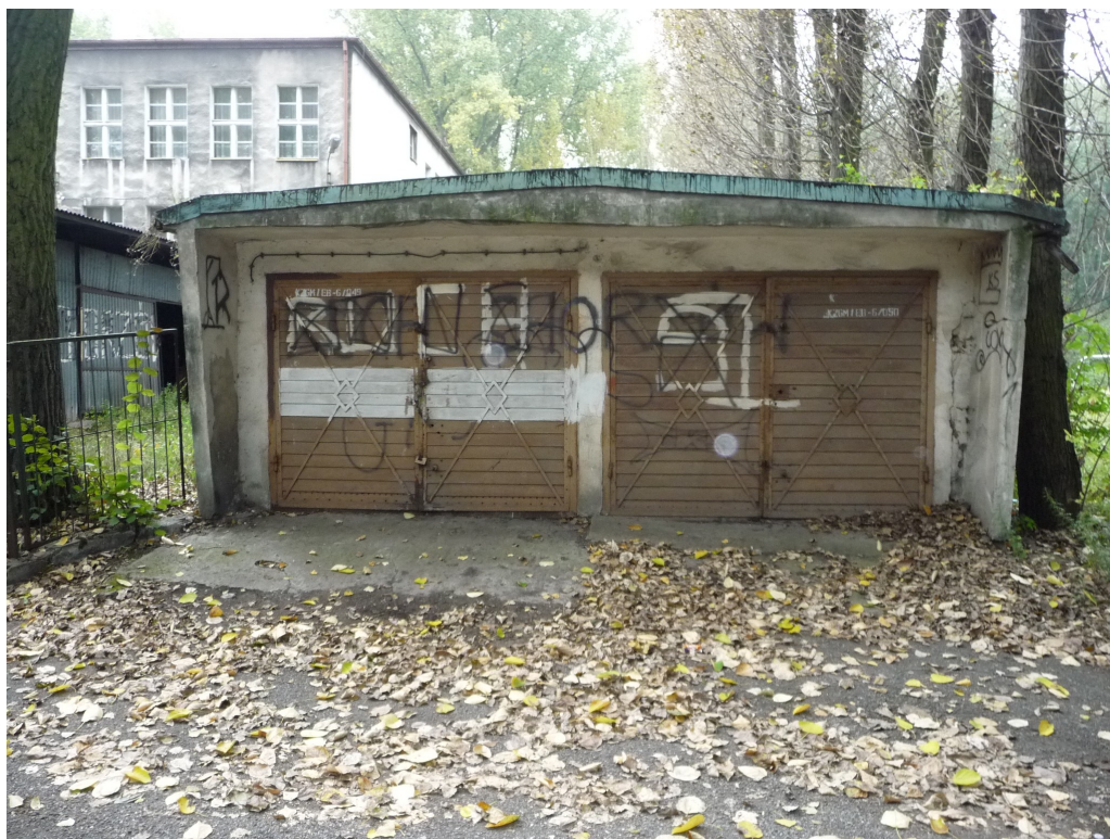
Fot. 13 Budynek gospodarczy C ul. Bocheńskiego 149 – elewacja północna.
