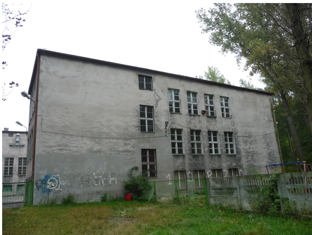
Fot. 6 Budynek szkolny ul. Bocheńskiego 149 – elewacja zachodnia zewnętrzna od strony boiska.
