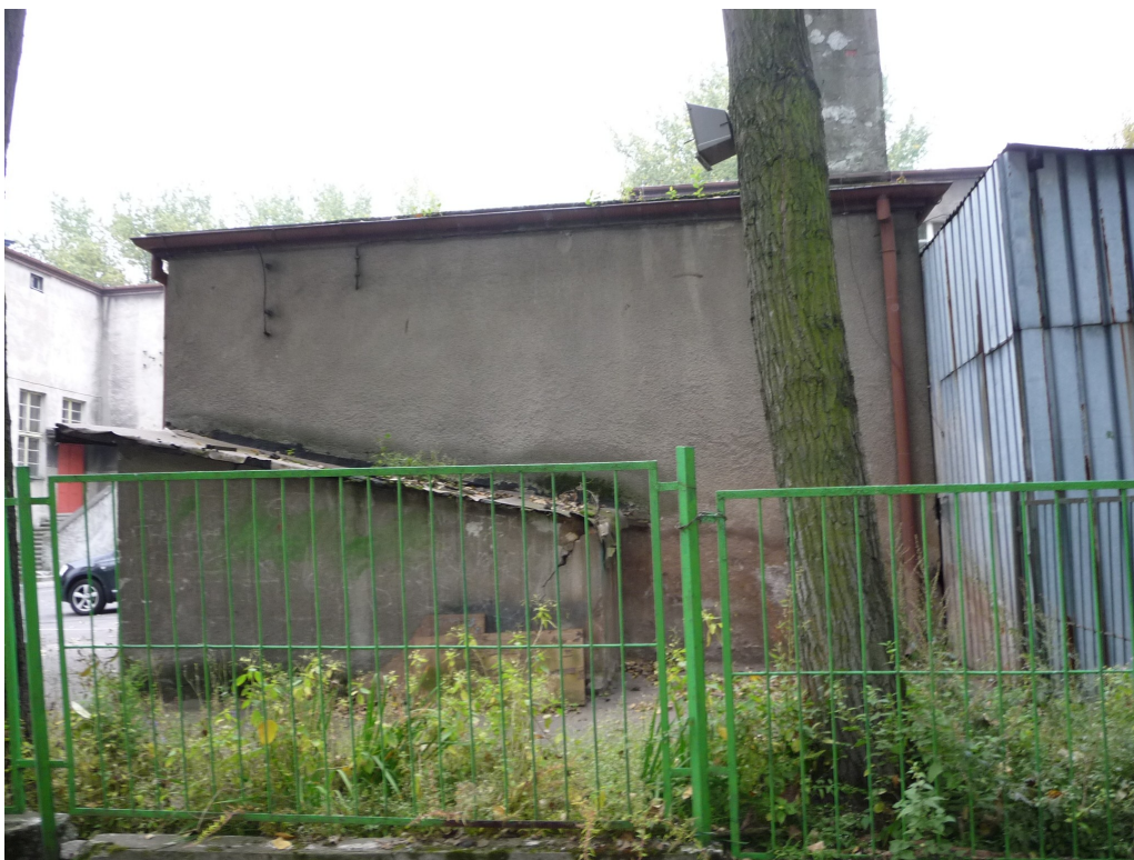
Fot. 9 Budynek gospodarczy A ul. Bocheńskiego 149 – elewacja północna.
