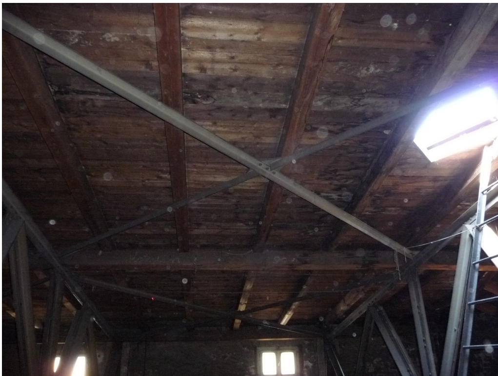
Fot. 29 Budynek szkolny ul. Bocheńskiego 149 – stalowe stężenie w poziomie górnych pasów kratownic nad salą gimnastyczną.
