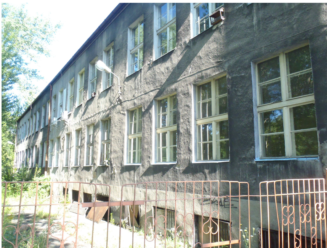
Fot. 7 Budynek szkolny ul. Bocheńskiego 149 – elewacja południowa.
