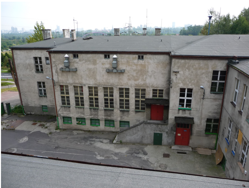
Fot. 1 Budynek szkolny ul. Bocheńskiego 149 – elewacja zachodnia wewnętrzna od dziedzińca
